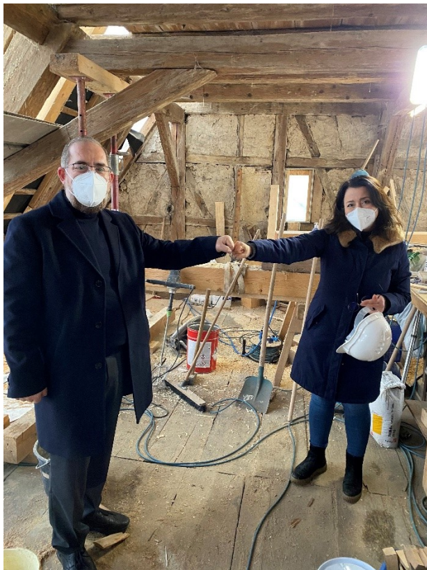
Pfr. Dr. Diradur Sardaryan und Ayla Cataltepe (MdL) auf der Baustelle der Hl. Kreuz Kirche
